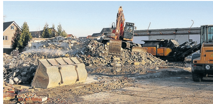
Seit vergangener Woche laufen die Abrissarbeiten an der Offlumer Straße. Im Sommer beginnt hier der Bau des „See-Kieker“. Foto: Boolke
